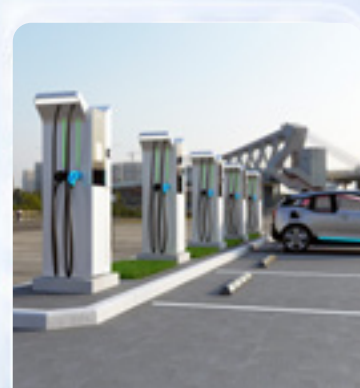
新能源充电站
